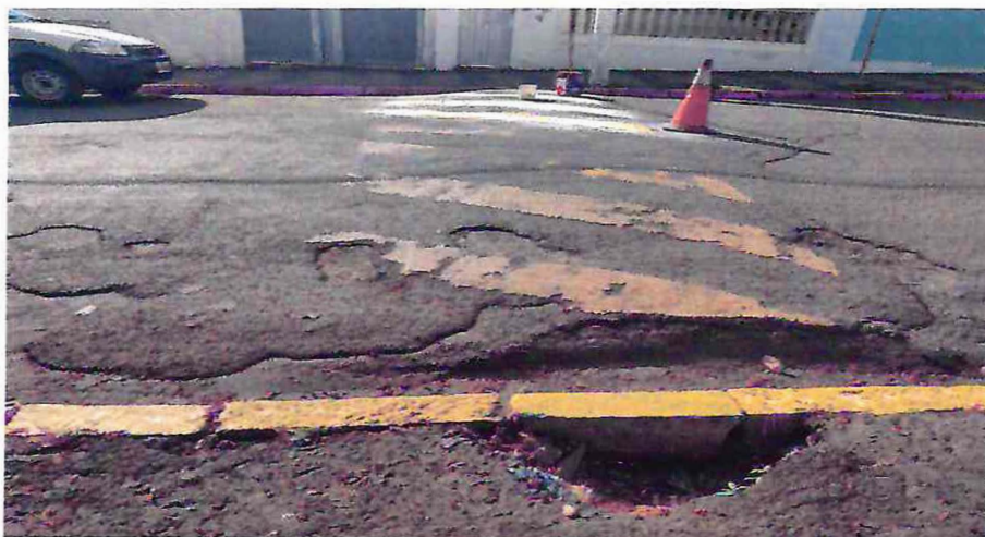
Ver César Ramos da Costa “Cesinha” – reparo em calçada localizada à Rua Pereira Bueno, Centro, proximidades da EMEIEF Rotary Clube
